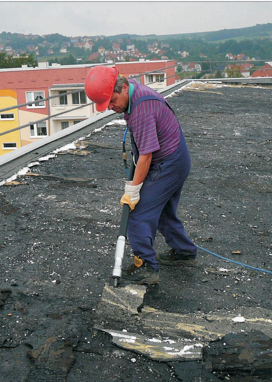
Lösen von verklebten Schweißbahnen in aufrechter Arbeitshaltung
